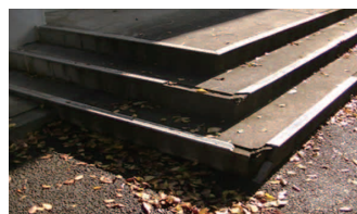
【飛び出した階段の角】
